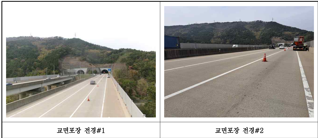
【사진 14.3.20】 교면포장 전경
