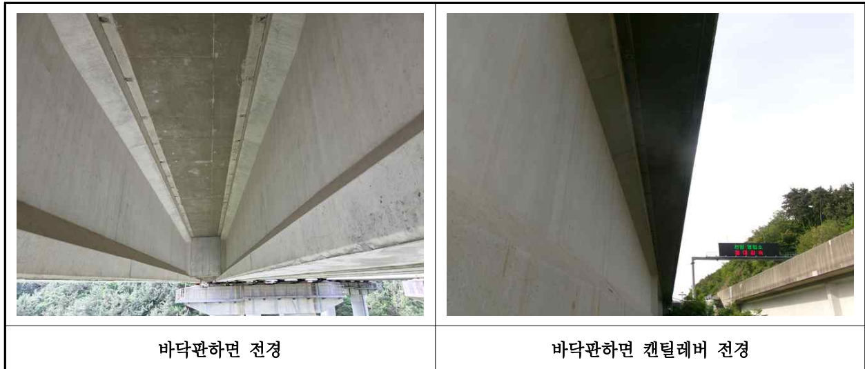
【사진 14.3.2】 바닥판하면 전경
