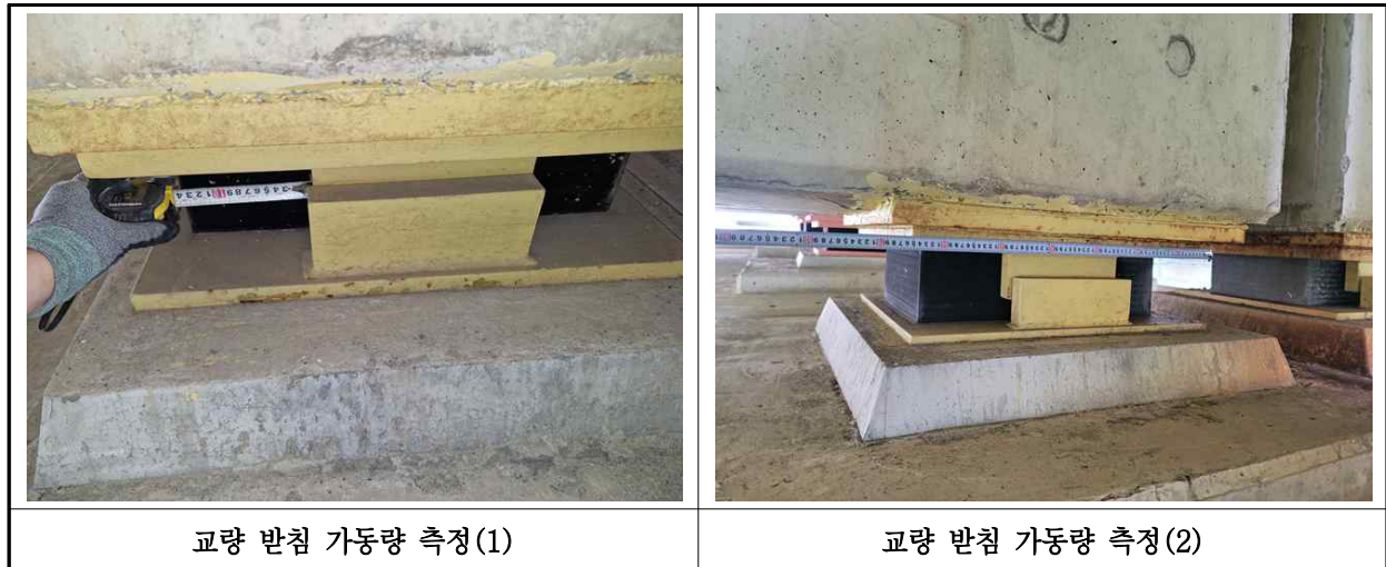
【사진 14.3.16】 교량받침 이동량 측정
