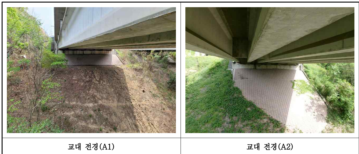
【사진 14.3.8】 교대 전경
