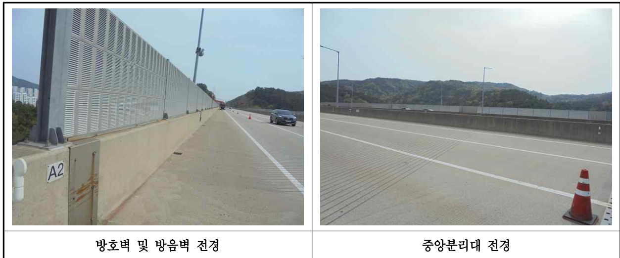
【사진 14.3.24】 방호벽 및 중분대 전경
