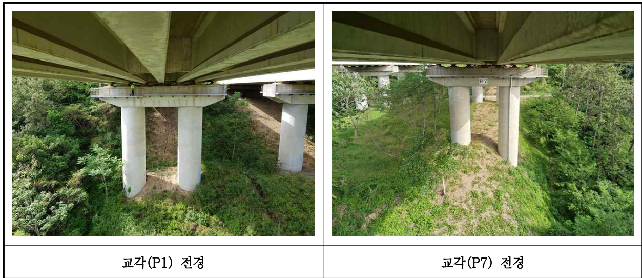
【사진 14.3.10】 교각 전경
