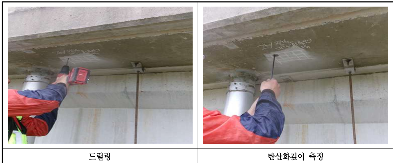
【사진 14.4.3】 탄산화 깊이 측정 현장사진
