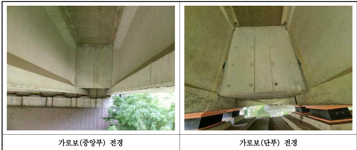
【사진 14.3.6】 가로보 전경
