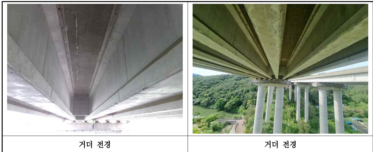
【사진 14.3.4】 거더 전경
