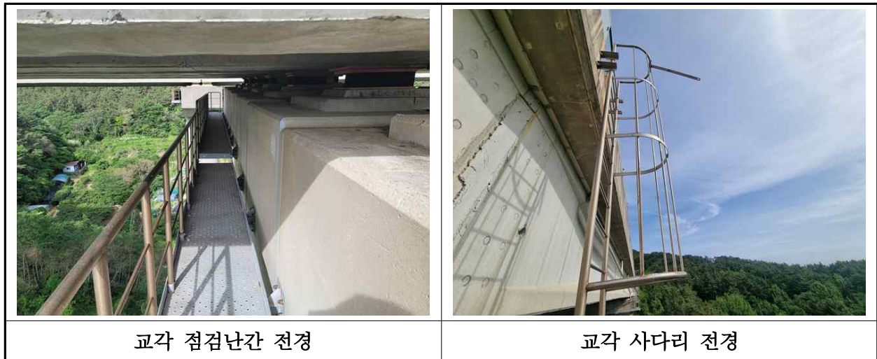
【사진 14.3.26】 교량 점검시설 전경
