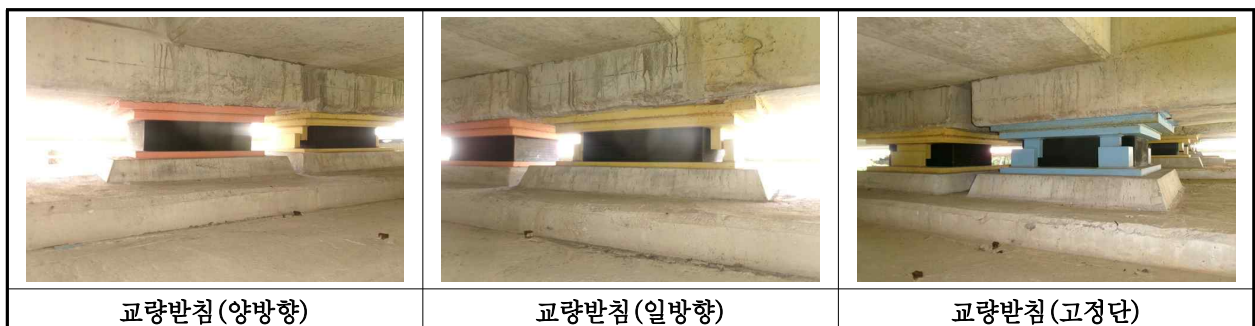
【사진 14.3.13】 교량반침 전경
