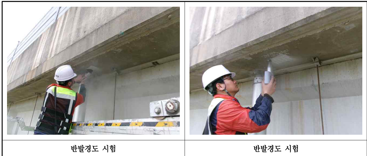
【사진 14.4.2】 반발경도시험 현장사진
