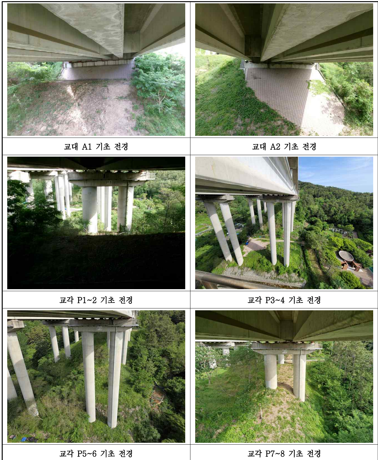
【사진 14.3.12】 기초 전경
