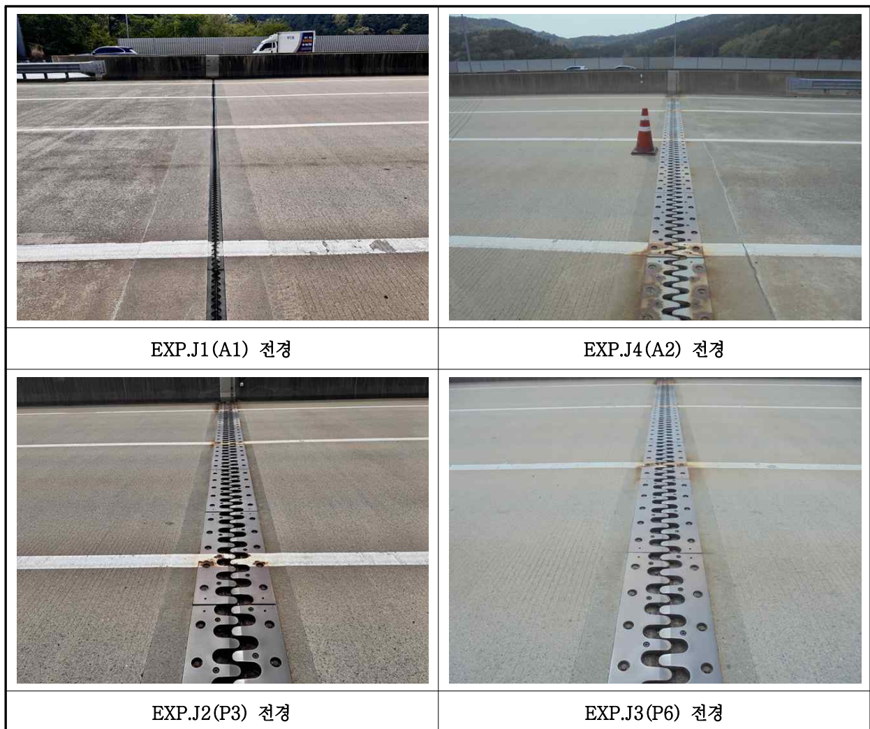
【사진 14.3.17】 신축이음장치 전경
